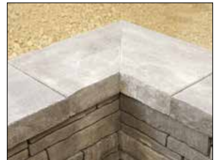
Diagram 11—45-degree miter
